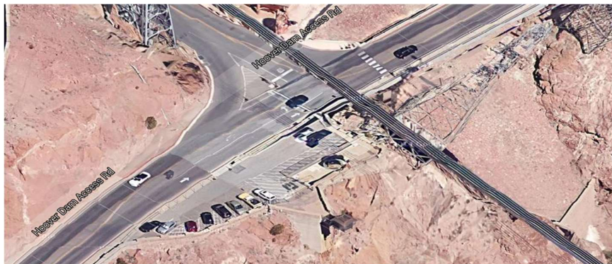
Presa Hoover entre Nevada y Arizona Autopista "93"
