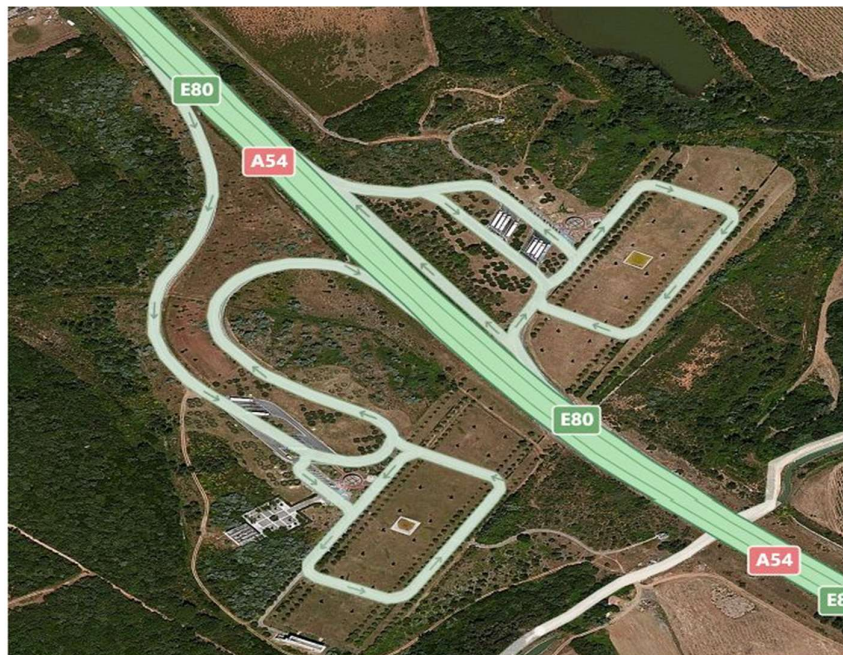
Área de Descanso en "Caissargues" entre Nimes y Arles. Región de la "Languedoc-Roussillon". Autopista E-80 y A-54
